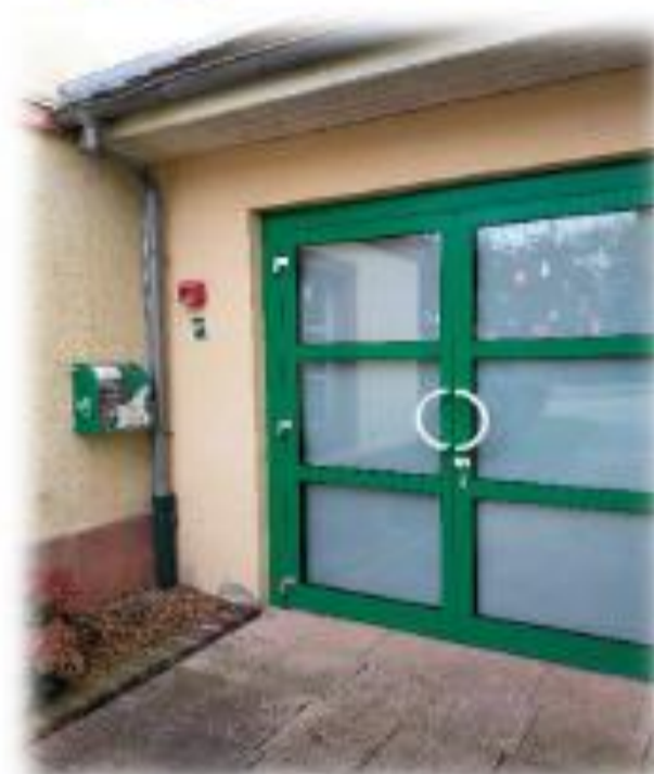
Entrée de la salle des fêtes Rue de l'Eglise
